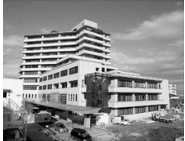
図 32. 新病院 2期工事竣工
