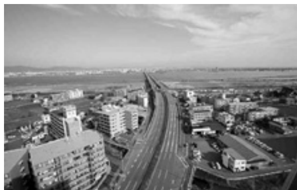
図 30. 屋上より吉野川を望む（国道 11 号線）
