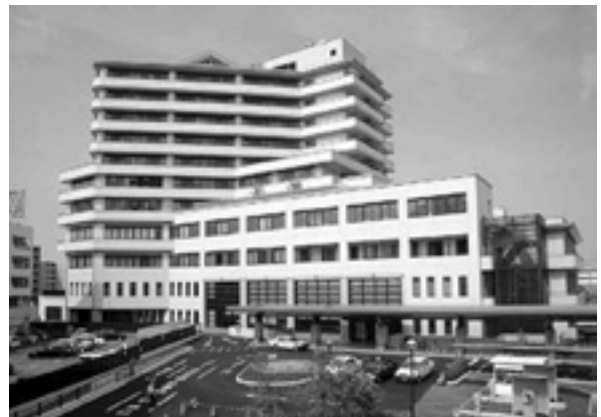
図 34. 新病院完成(平成22年6月)
