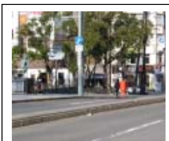
両国橋の状況（両国橋中央部から北西方向に撮影）
