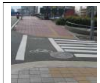
かちどき橋の状況（北詰の上流側歩道を南方向に撮影）
