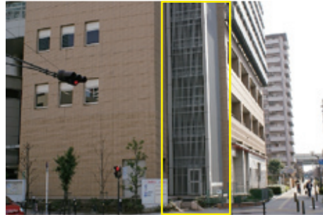
本体建築物と一体感のあるデザインとした屋外階段の設置例
