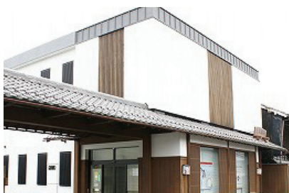
屋上にシンプルなルーバーを配置して設備が直視されないように工夫した例
