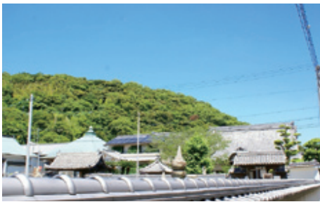
勾配屋根や棟高さが整い屋根の連続性が感じられる例
