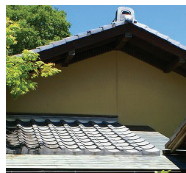
土壁色（茶系色）の吹付塗装壁の例
