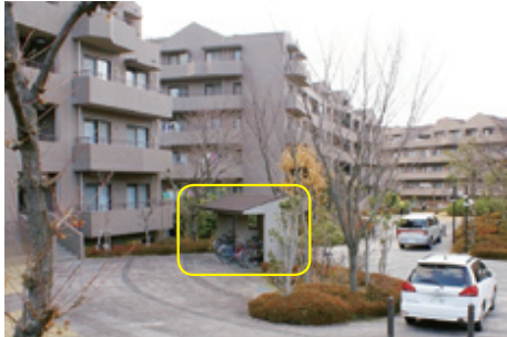
駐輪場の外観色彩や周りの植栽により目立たせないように工夫した例
