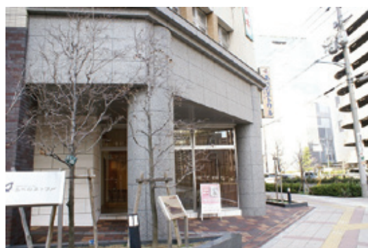
外壁に石材を用いて存在感のあるものとしている例
