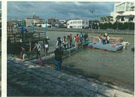
写真2 仮設橋の利用状況
