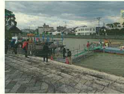
写真1 仮設橋の設置状況
