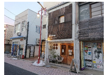
空き店舗のリノベーション
