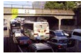
国道 192 号アンダー部
