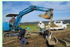
コンクリート水路の更新
