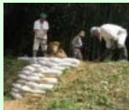
漏水箇所の補修
