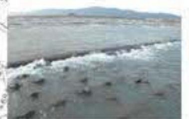
越流時の様子に 1tブロックは段差がない
