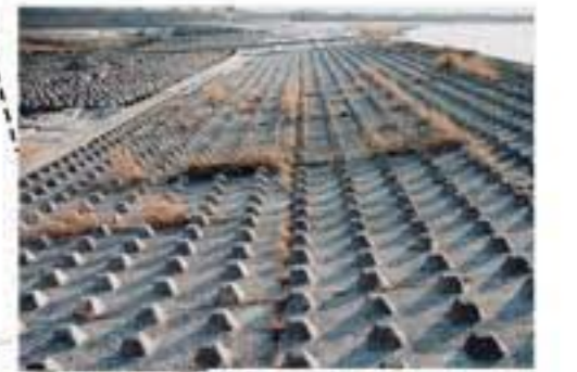
未補修 (40年以上経っても健全) 未補修部分突起付コンクリート
