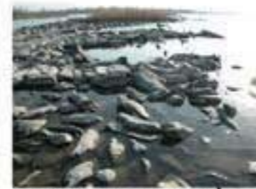
上堰② (青石の破損状況)
