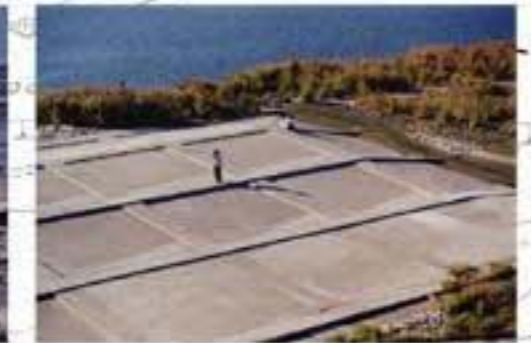
建設省による強固な補修部分 (30年以上経過しても健全状態)
