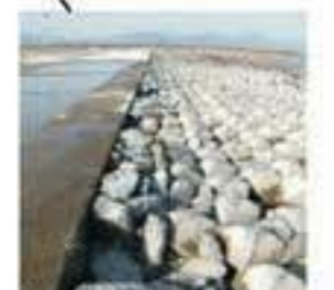
1tブロック設置箇所 (堰との間に段差がない)
