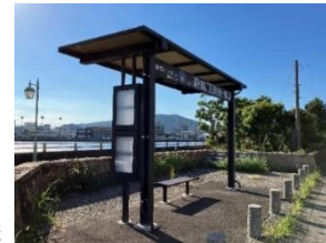
南末広町(上り)停留所に設置した上屋
