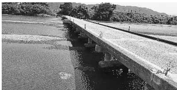
旧 弁天橋 (潜水橋)
