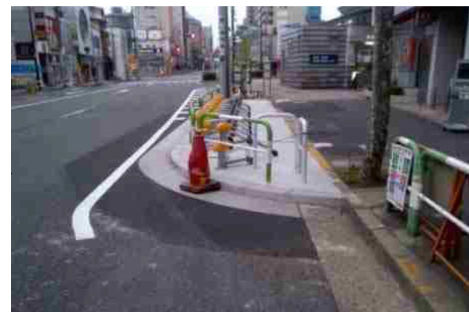
歩道の一部を活用した駐輪場整備 (東京都豊島区)
