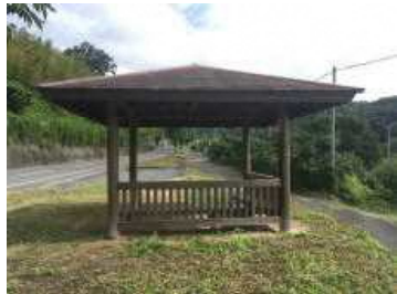
遍路小屋 (板野郡板野町)
