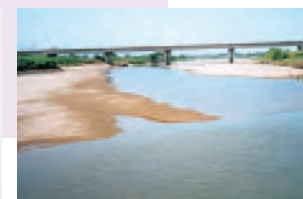
10 干潮時に砂礫浜が出現する鮎喰川下流域
