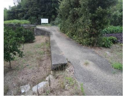
⑥コンクリート舗装
