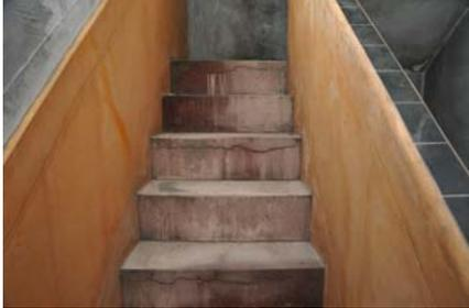
**25** 鉄筋コンクリート階段の亀裂
