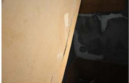
**27** 階段桁桁部コンクリートの割損
