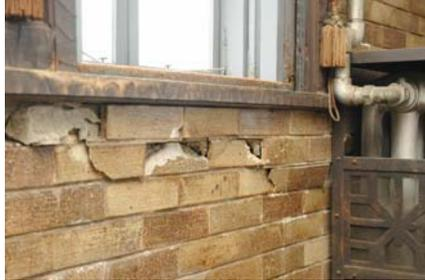
**10** 壁タイル張の割損、脱落
