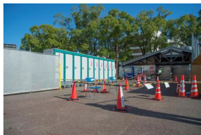
密集回避のため仮設トイレを設置
