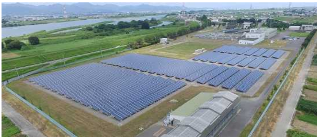
図7 太陽光発電設備（第十浄水場）
