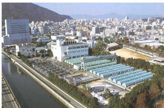
中央浄化センター
