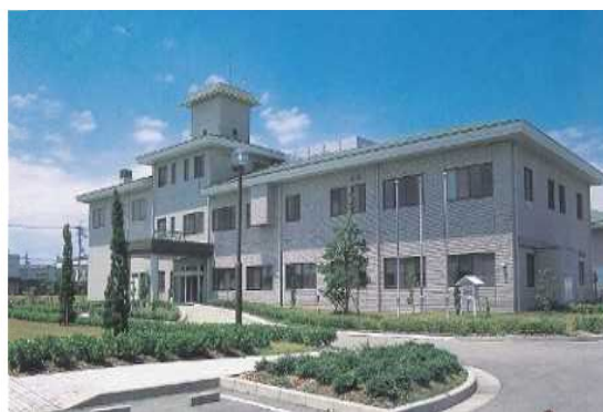
北部浄化センター
