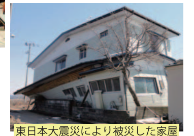
東日本大震災により被災した家屋
